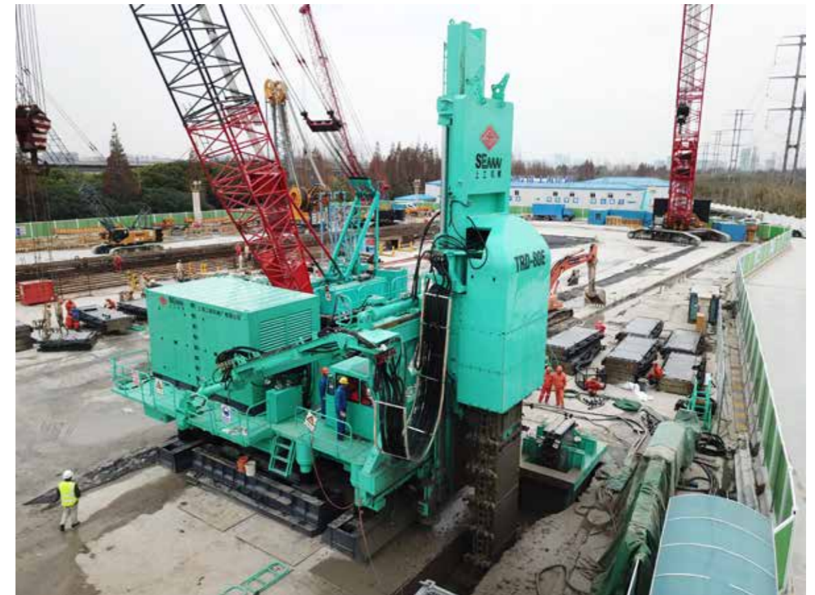
TRD-E Construction Site
